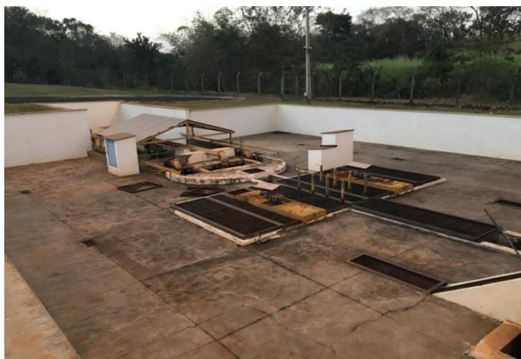
**Foto 3.67 – Vista da Caixa de areia mecanizada e do poço de sucção de EEE**
