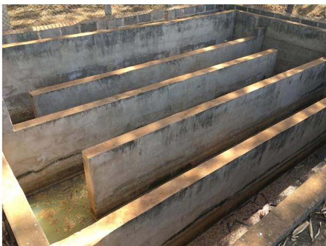
Foto 3.101 – Chicanas de desinfecção sem fluxo de efluentes
