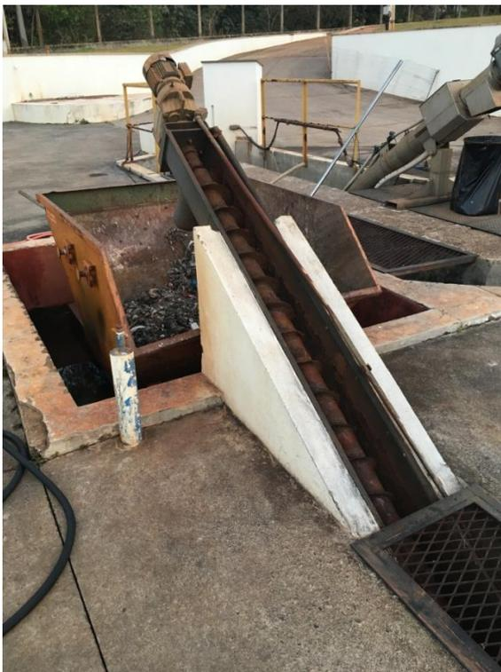
**Foto 3.66 – Detalhe da retirada de sólidos da caixa de areia mecanizada da Estação Elevatória**
