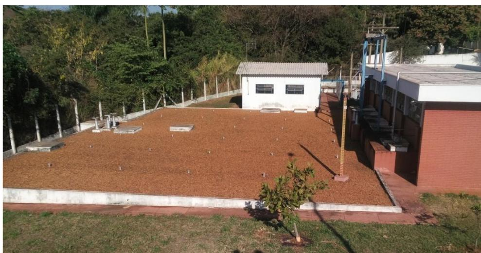
Foto 3.10 – Vista do reservatório de contato enterrado com volume de 1.000 m<sup>3</sup>
