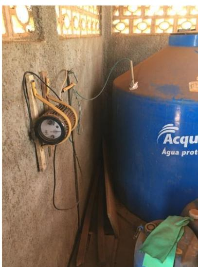
Foto 3.102 – Dosador de cloro para desinfecção do efluente
