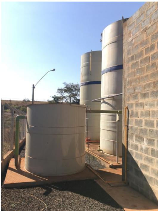
Foto 3.115 – Vista do tanque de recirculação de lodo
