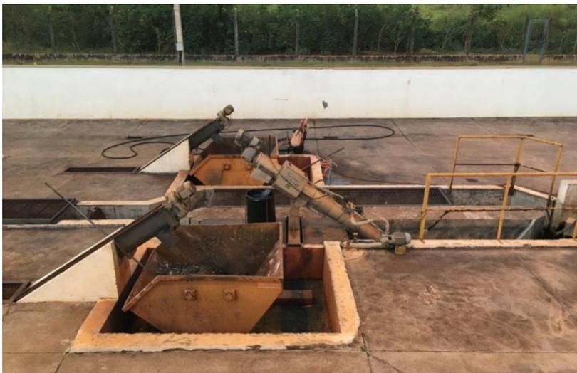
Foto 3.68 – Vista das caçambas de retirada de sólidos da EEE
