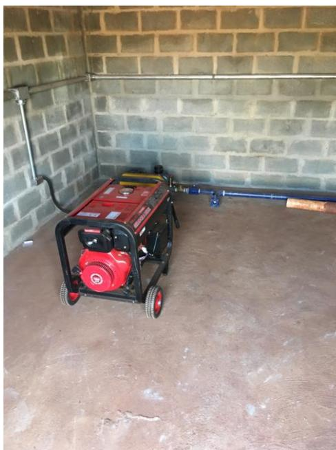
Foto 3.116 – Detalhe do gerador de energia da ETE
