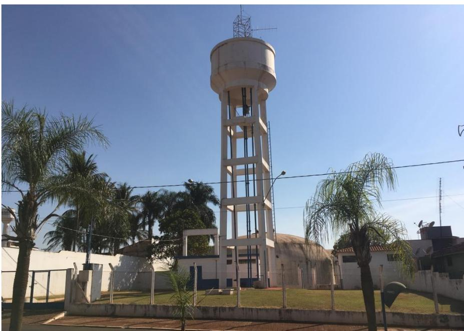
**Foto 3.15 – Vista do reservatório elevado do Centro de Reservação Estação – 50 m<sup>3</sup>**
