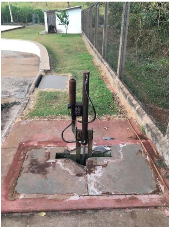
Foto 3.64 – Detalhe do controle de vazão da entrada da EEE Vila São Jorge
