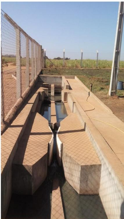
**Foto 3.97 – Vista do gradeamento, caixa de areia e Calha Parshall da ETE de Aparecida do Salto**
