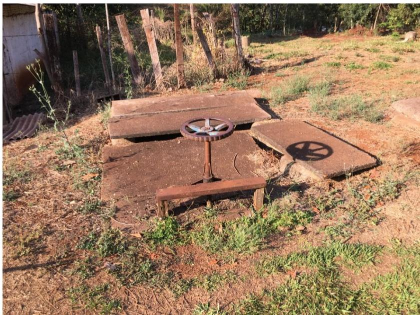
Foto 3.4 – Detalhe do volante da tubulação da captação
