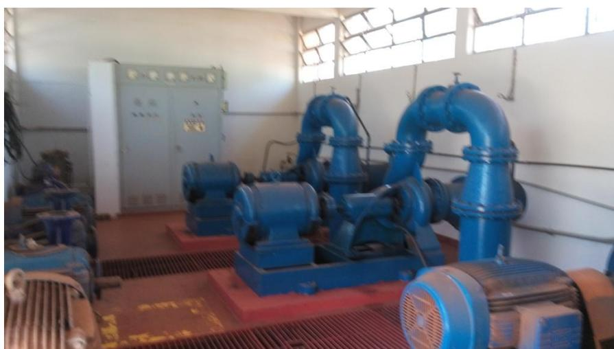
Foto 3.36 – Vista dos conjuntos motobomba que realizam a reversão de fluxo da limpeza dos filtros
