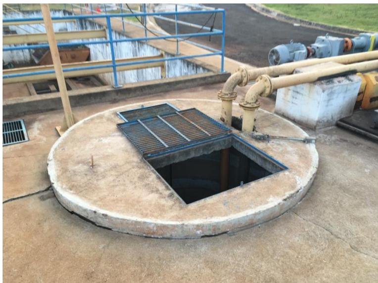
Foto 3.75 – Poço de Sucção da EEE Nosso Teto
