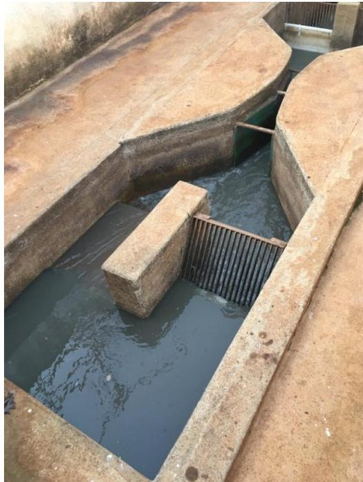
**Foto 3.73 – Vista da entrada do efluente bruto na EEE Nosso Teto, do gradeamento e da Calha Parshall**
