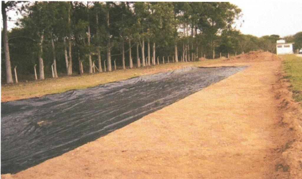
**Foto 03- Área de preparo do terreno com lona em polietileno de baixa densidade 1,5mm.**
