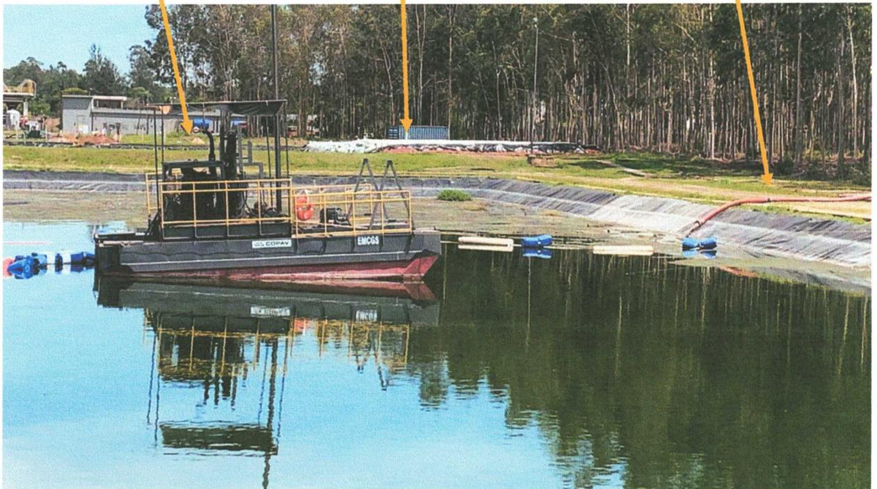
Imagem do coletor em processo de remoção de lodo e leito de secagem.
