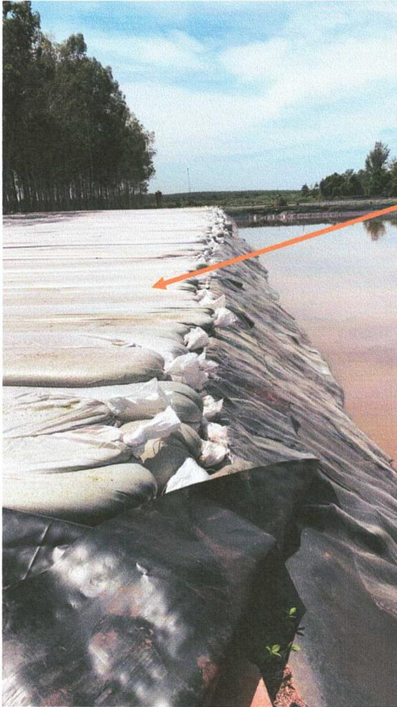
**Acondicionamento dos bags empilhados em camadas para reduzir espaço e para que o peso ajude a espremer o líquido e assim acelere o processo de desaguamento. O líquido drenado retorna para a lagoa anaeróbia por gravidade conforme demonstra imagem ao lado. Não há necessidade de caixa de coleta de líquido pois o mesmo retornará para a lagoa.**
