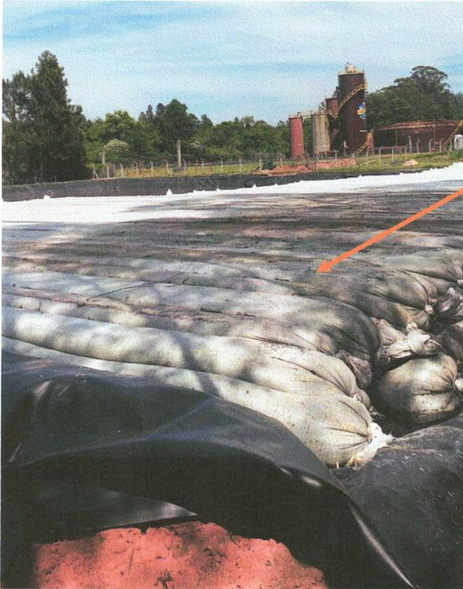
**Bags acondicionados e empilhados para facilitar e acelerar o processo de desaguamento.**
