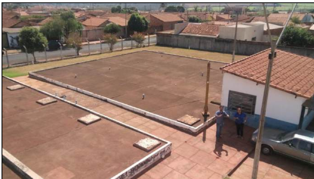
Foto 3.20 – Vista do Reservatório Enterrado 2 de 500 m 3 do Centro de Reserva Guanabara
