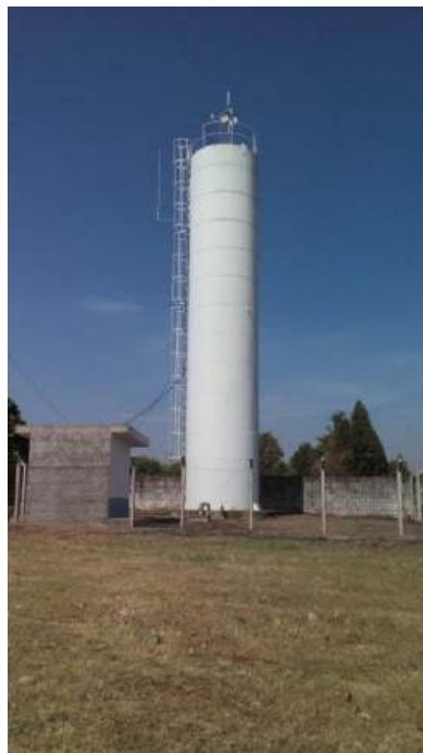
Foto 3.29 – Vista do Reservatório Apoiado Primavera
