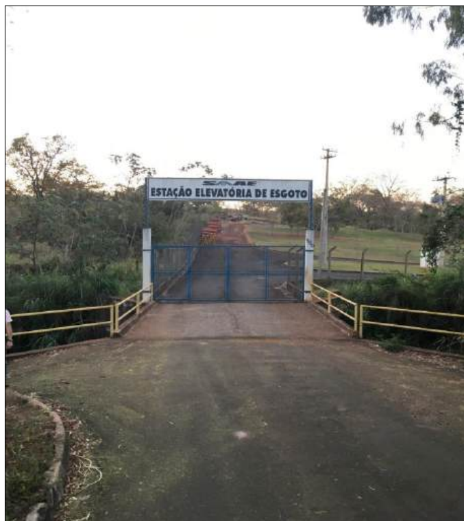
Foto 3.62 – Vista da Entrada da Estação Elevatória Vila São Jorge
