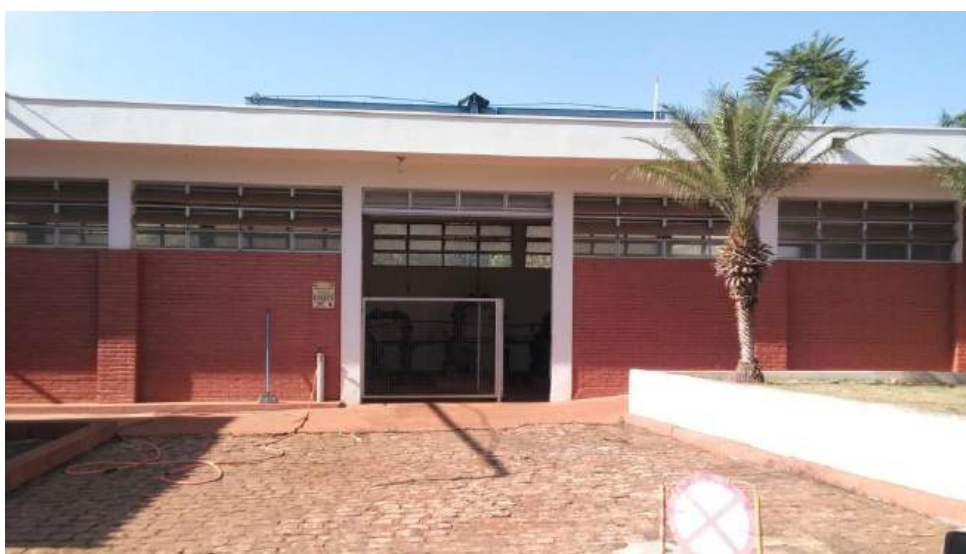
Foto 3.32 – Vista da EEAT 1
