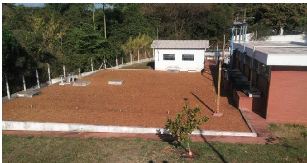
Foto 3.10 – Vista do reservatório de contato enterrado com volume de 1.000 m 3
