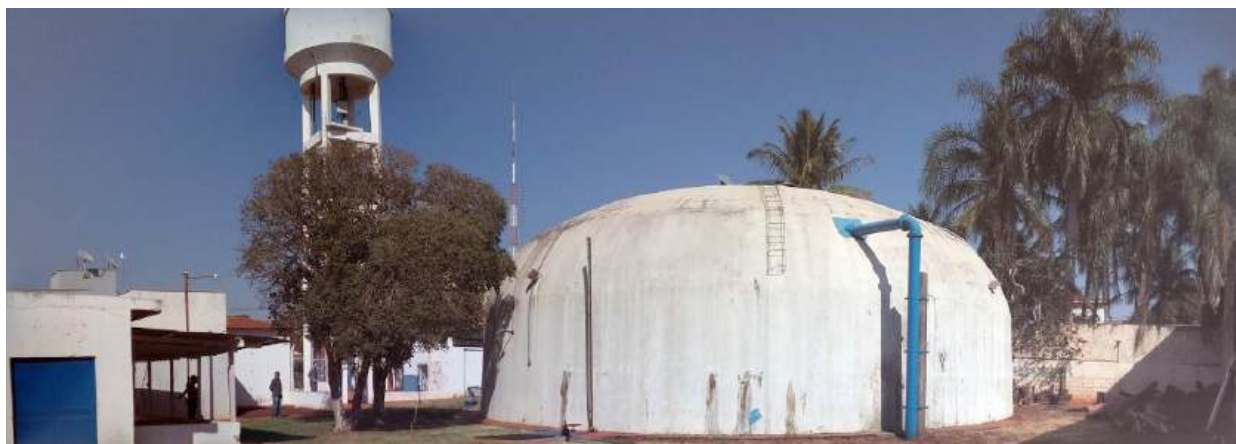
Foto 3.13 – Vista do Centro de Reservação Estação
