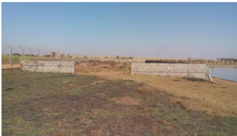
Foto 3.98 – Vista da baía de secagem de lodo da ETE
