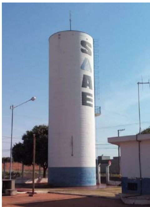
Foto 3.21 – Reservatório Elevado de 100 m 3
