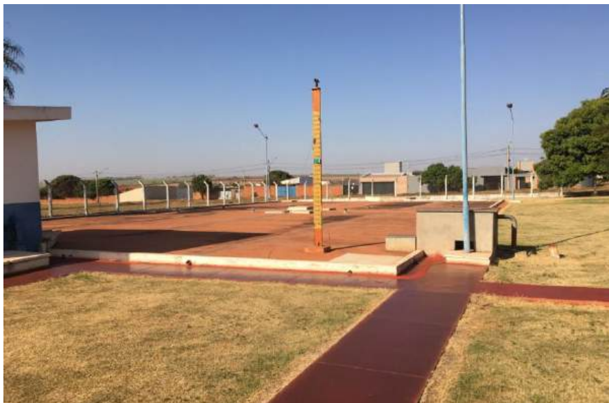
Foto 3.23 – Vista do Reservatório Enterrado de 1.000 m 3
