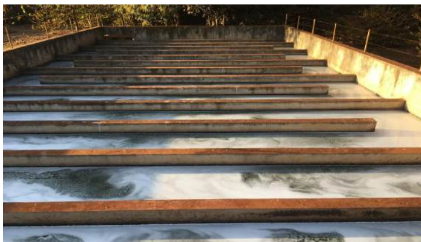
Foto 3.90 – Vista da chicana com efluente tratado
