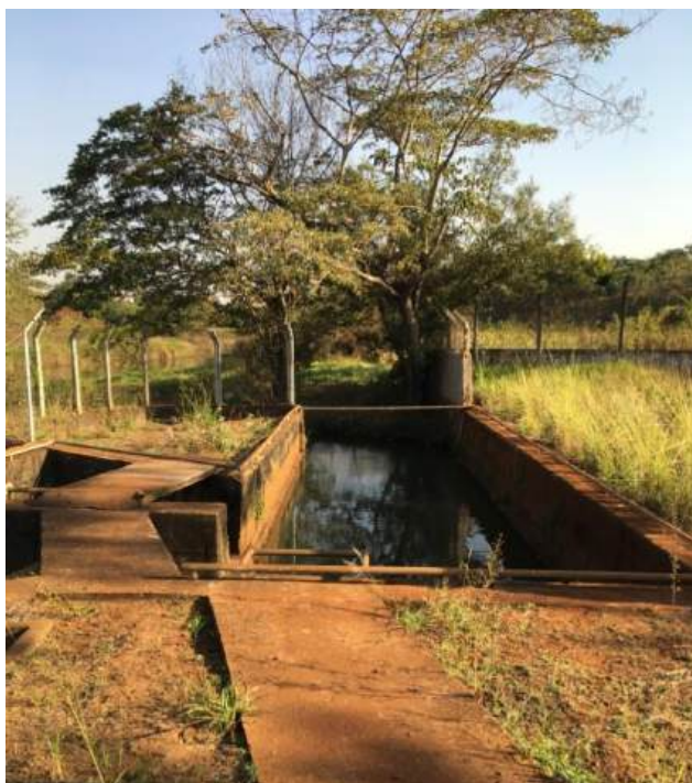
Foto 3.3 – Detalhe da captação do rio do Carmo
