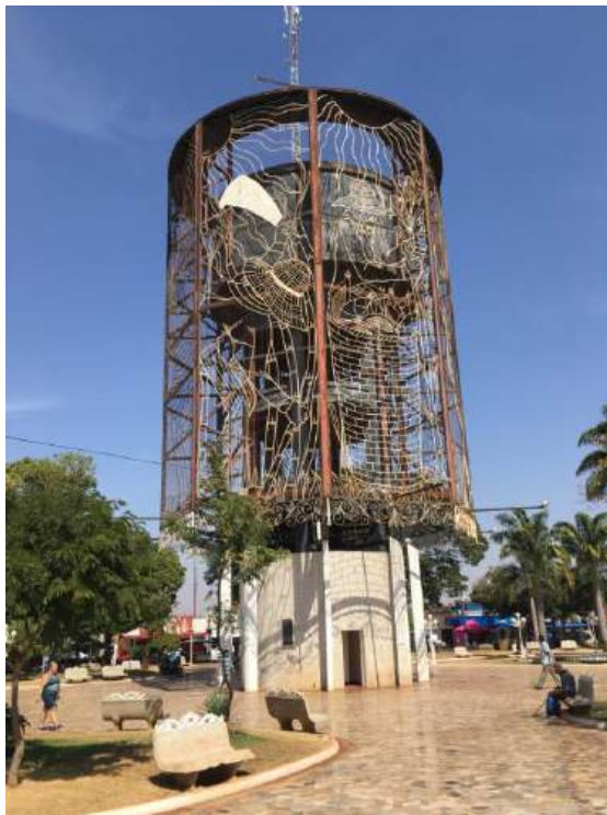
Foto 3.31 – Vista do reservatório elevado Praça
