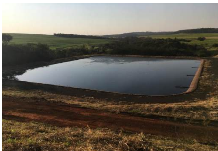
Foto 3.85 – Vista da segunda Lagoa Anaeróbia da ETE de Ituverava
