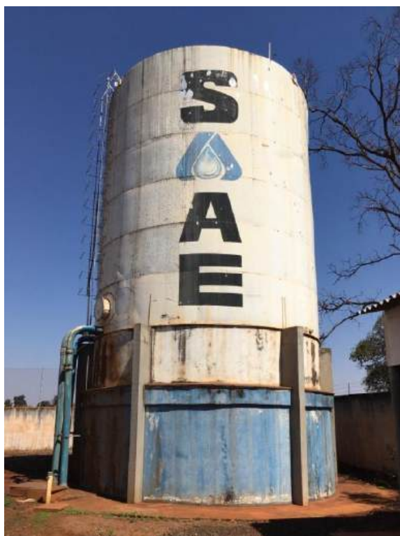
Foto 3.55 – Vista do reservatório elevado REL – 1 do Centro de Reserva do distrito de São Benedito da Cachoeirinha
