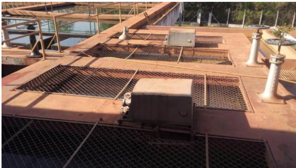
Foto 3.6 – Detalhe dos Floculadores
