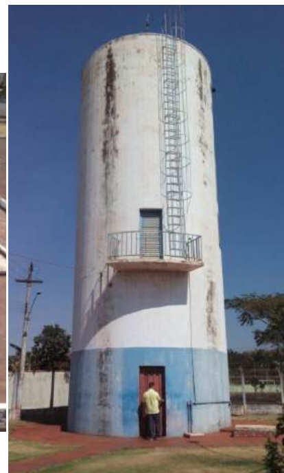
Foto 3.19 - Reservatório Elevado Guanabara – 180 m 3
