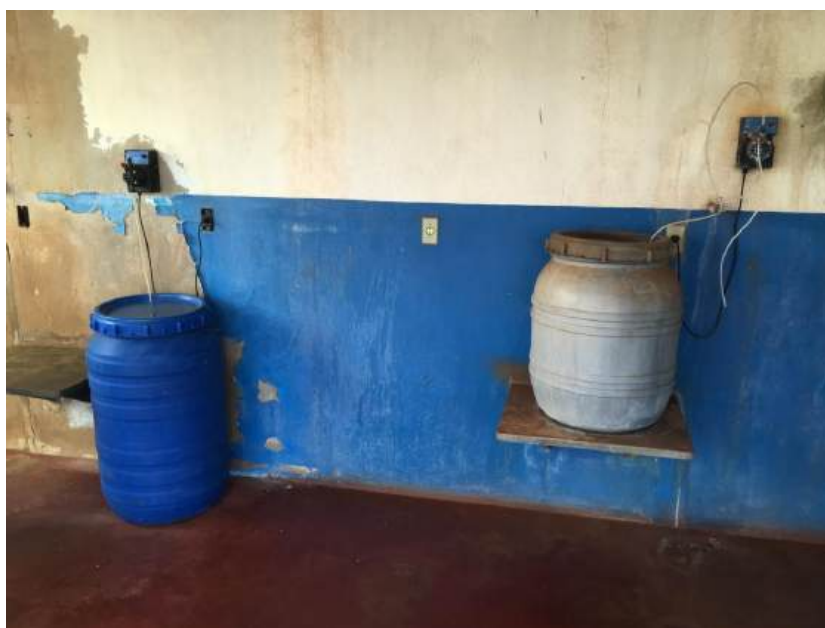
Foto 3.53 – Detalhe da dosagem dos produtos químicos de São Benedito da Cachoeirinha.
