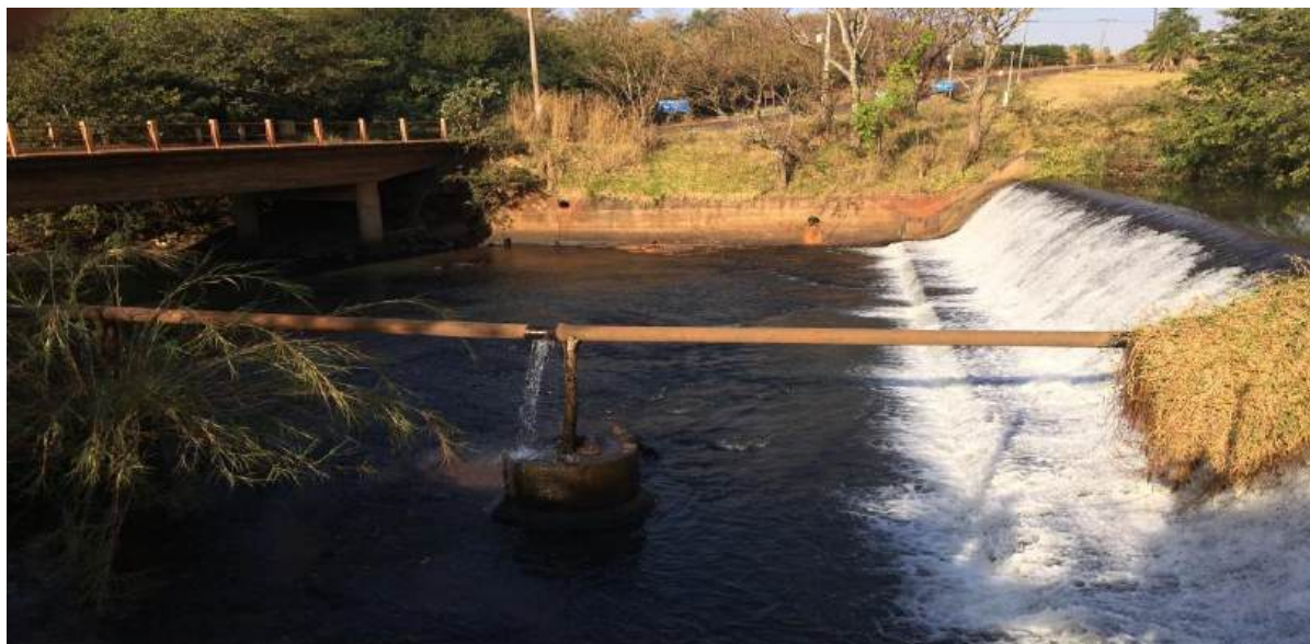
Foto 3.1 – Barramento no Rio do Carmo
