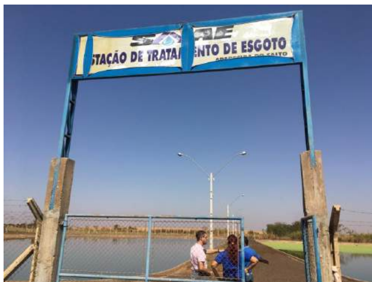
Foto 3.96 – Entrada e identificação da ETE de Aparecida do Salto
