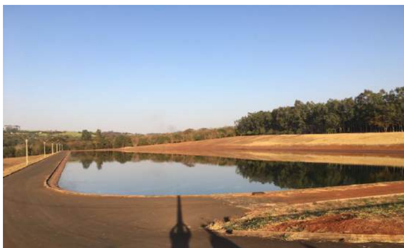
Foto 3.87 – Vista da primeira Lagoa Facultativa da ETE de Ituverava.
