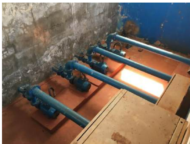
Foto 3.42 – Vista da EEAT localizada dentro da área do CR Guanabara
