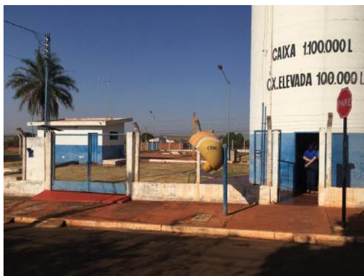
Foto 3.22 – Vista do acesso ao Centro de Reserva Tropical
