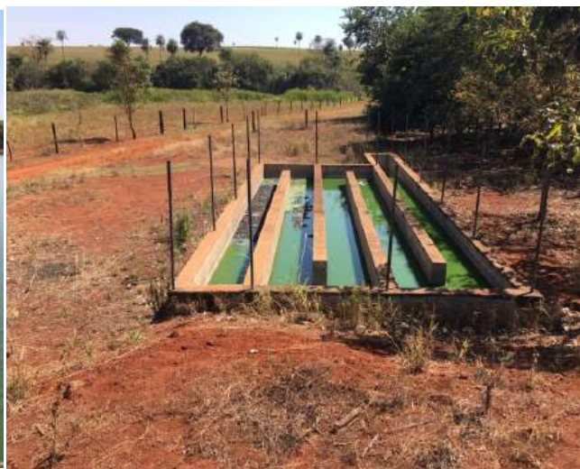
Foto 3.108 – Chicanas da desinfecção da ETE de São Benedito da Cachoeirinha
