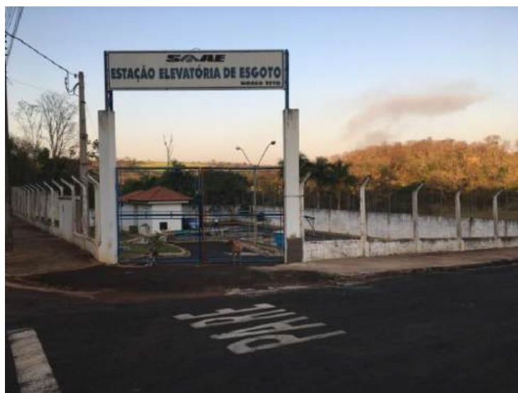
Foto 3.72 – Vista da entrada da EEE Nosso Teto
