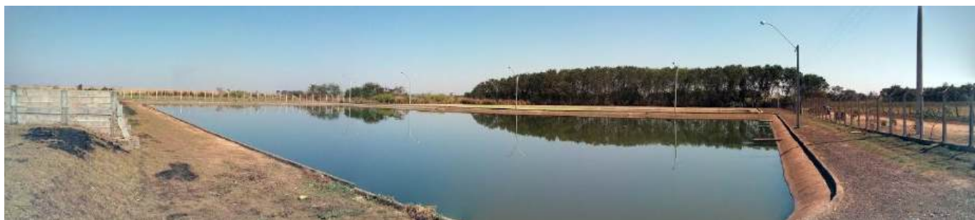
Foto 3.99– Vista da Lagoa - ETE de Aparecida do Salto
