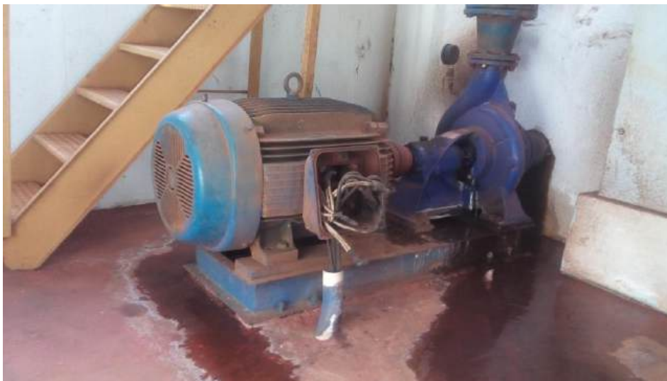
Foto 3.37 – Vista dos conjuntos motobomba que abastecem o CR Tropical
