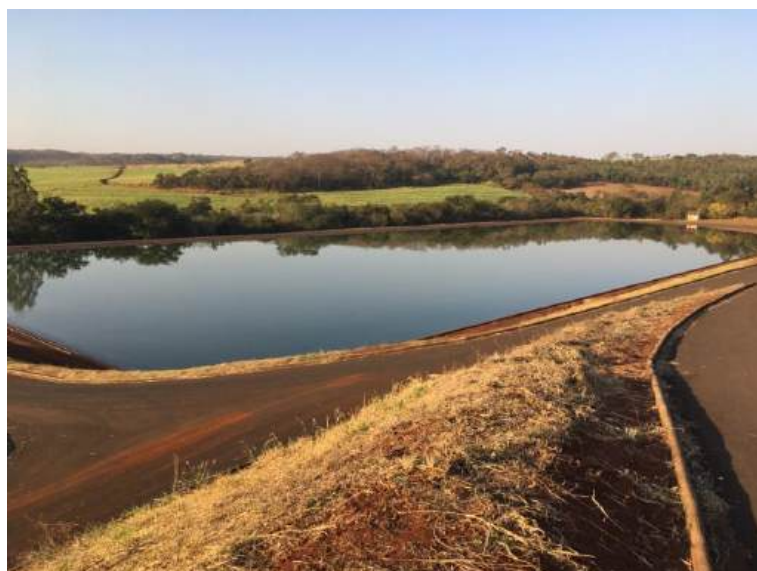
Foto 3.86 – Vista da segunda Lagoa Facultativa da ETE de Ituverava
