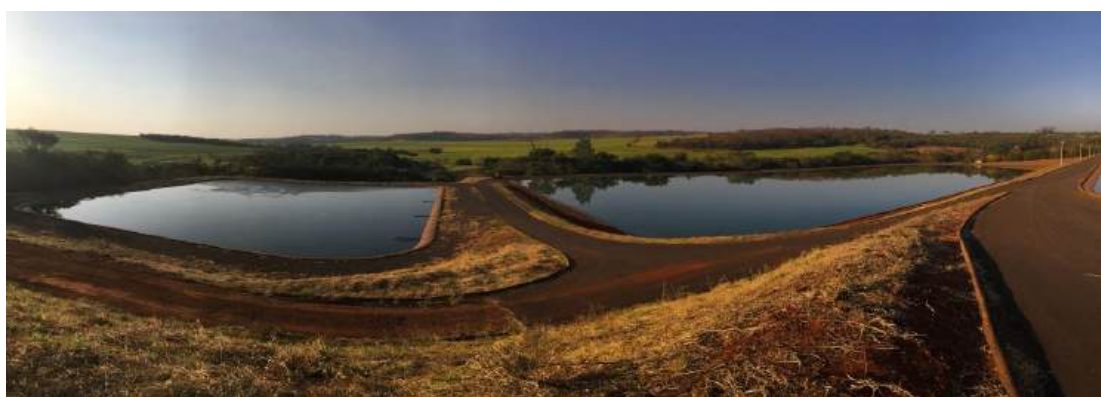
Foto 3.84– Vista do segundo conjunto de Lagoas da ETE de Ituverava
