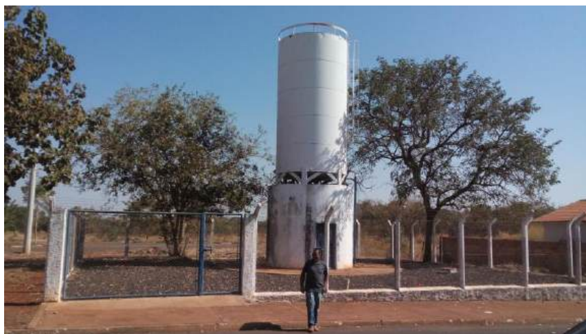
Foto 3.30 – Vista do Reservatório Elevado Nosso Teto
