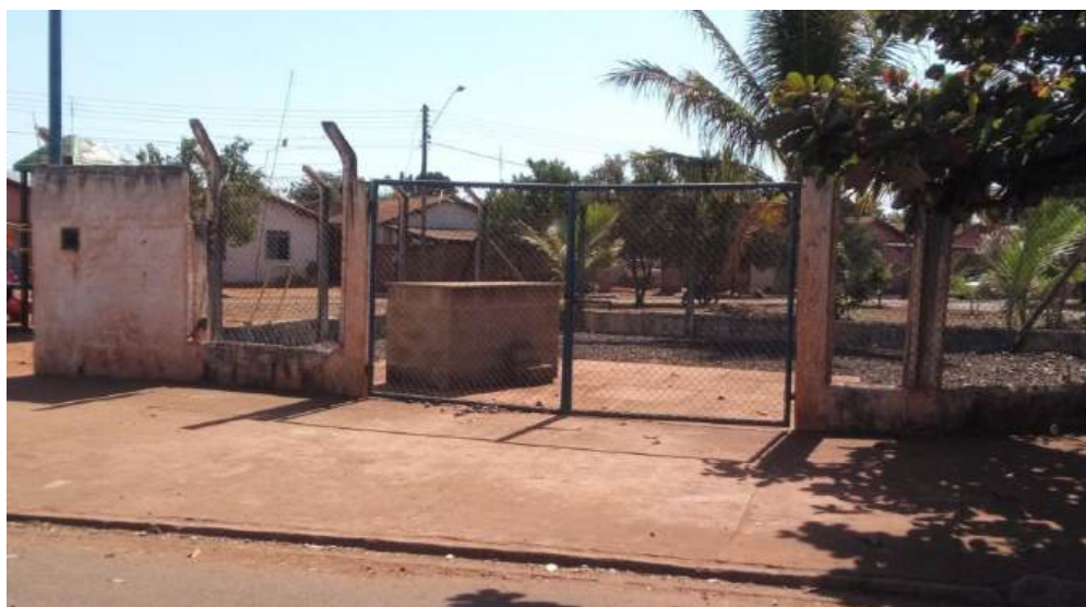
Foto 3.46 – Vista da área do Poço PP-02 de Aparecida do Salto.
