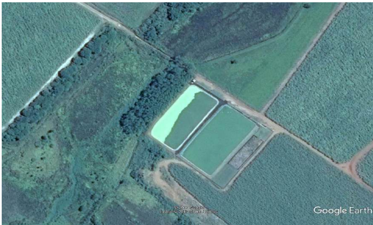
Foto 3.95 – Vista Aérea da ETE de Aparecida do Salto
