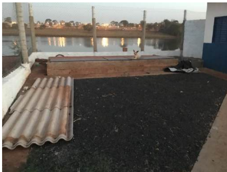
Foto 3.79 – Vista da entrada do efluente bruto na EEE Tropical, do gradeamento e da Calha Parshall
