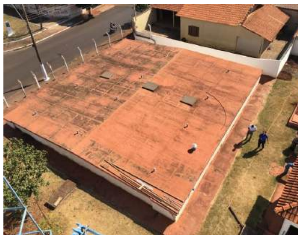
Foto 3.27 - Reservatório Enterrado 2 com 900 m 3
