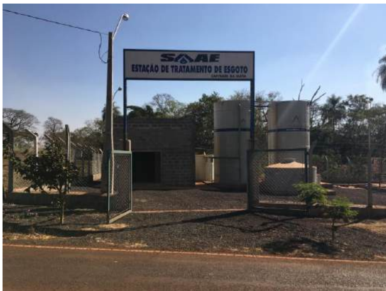
Foto 3.110 – Vista da Entrada da ETE de Capivari da Mata
