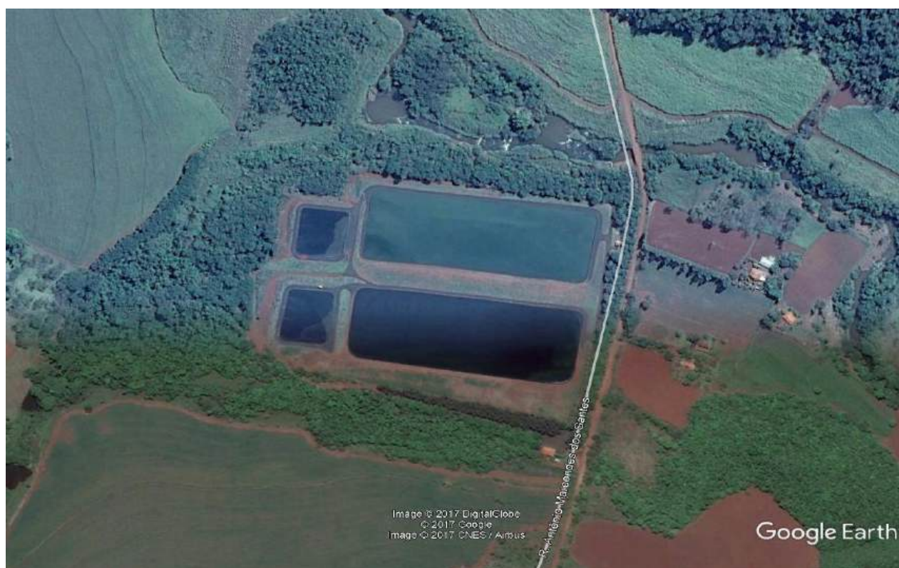
Foto 3.80 – Vista aérea da Estação de Tratamento de Esgotos de Ituverava
