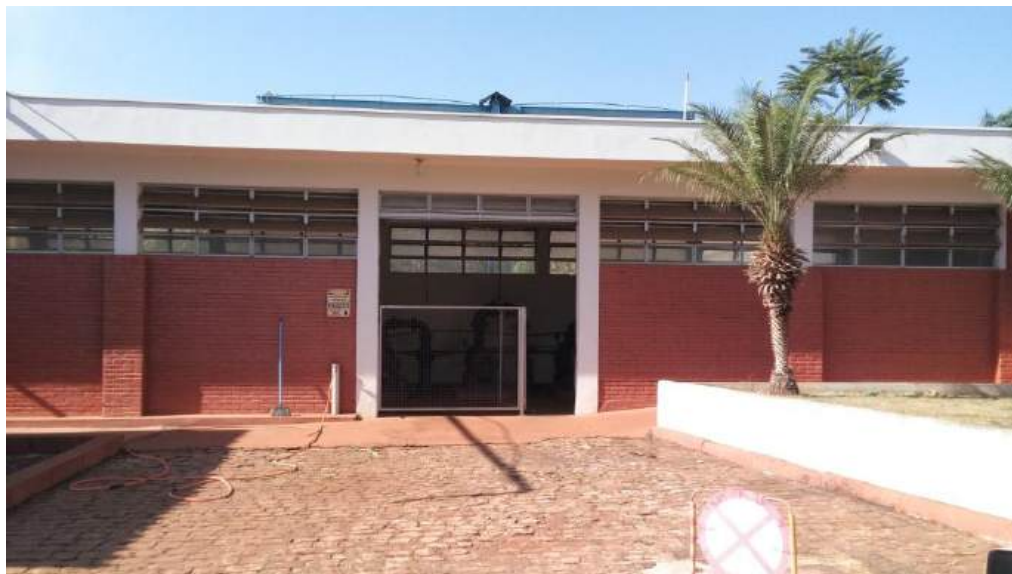
Foto 3.12 – Vista da Estação Elevatória de Água Tratada 1
