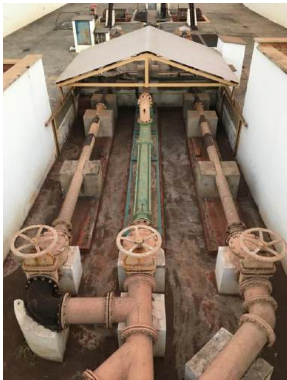
Foto 3.70 – Vista do barrilete da EEE São Jorge.
