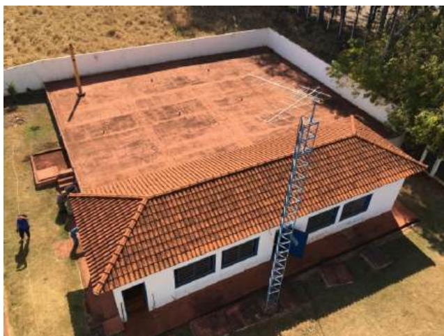
Foto 3.26 - Reservatório Enterrado 1 de 900 m 3 e EEAT COHAB
