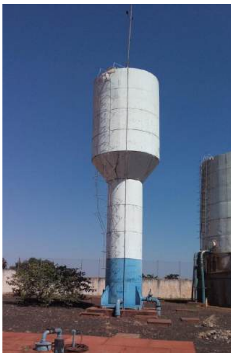
Foto 3.56 – Vista do reservatório apoiado RAP - 1 do Centro de Reserva do distrito de São Benedito da Cachoeirinha
