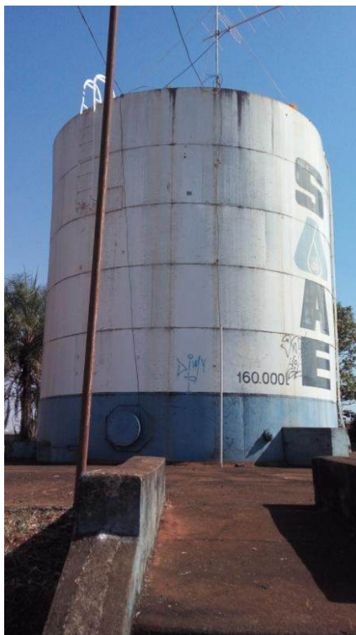
Foto 3.16 – Vista do reservatório apoiado do Centro de Reserva Moacir França – 170 m 3
