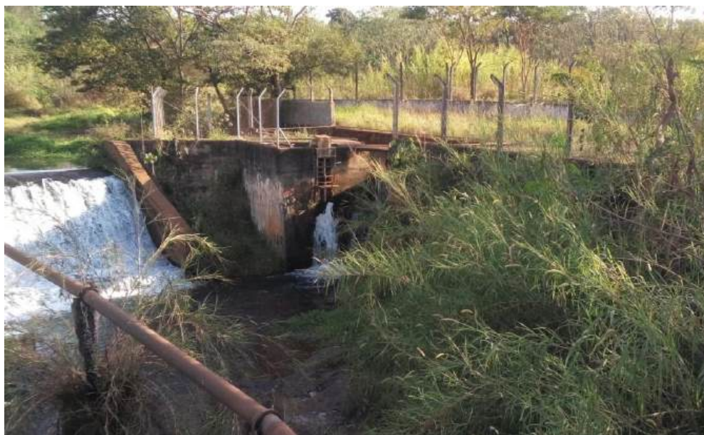
Foto 3.2 – Vista da captação do Rio do Carmo junto ao barramento
