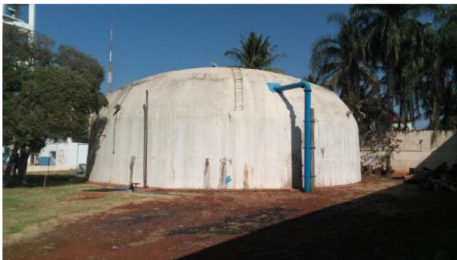
Foto 3.14 – Vista do reservatório apoiado do Centro de Reservação Estação – 1.000 m 3
