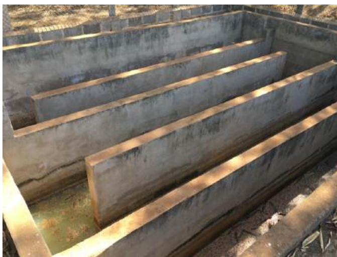
Foto 3.101 – Chicanas de desinfecção sem fluxo de efluentes
