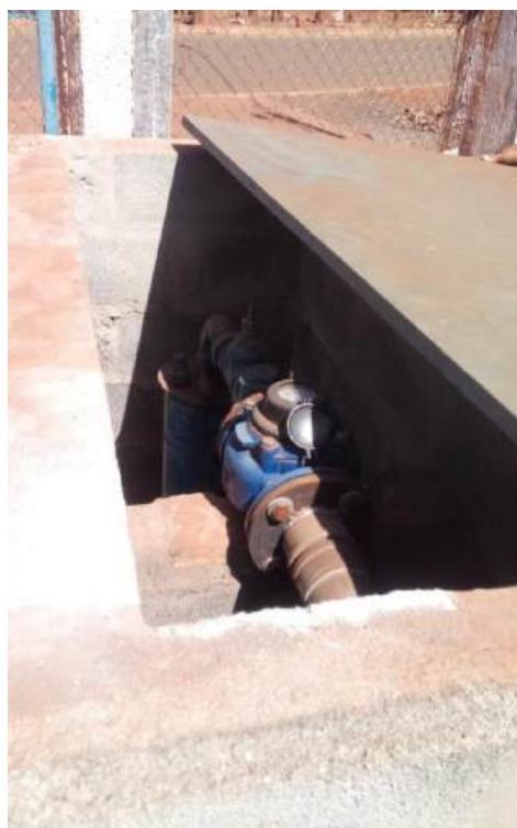
Foto 3.47 – Detalhe do Poço PP-02 de Aparecida do Salto.
