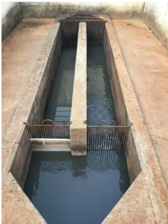
Foto 3.74 – Vista da caixa de areia e novo gradeamento
