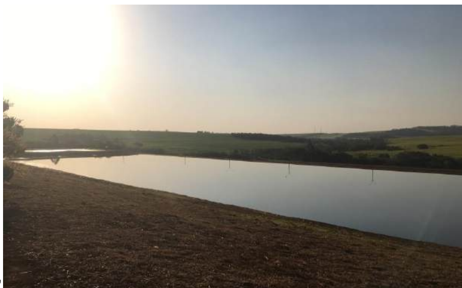
Foto 3.83 – Vista da Lagoa Facultativa e ao fundo a Lagoa Anaeróbia do primeiro conjunto da ETE Ituverava.
