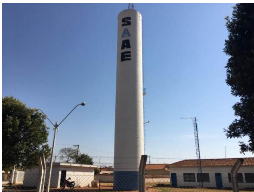
Foto 3.28 – Vista do Reservatório Elevado com duas câmaras e da EEAT COHAB
