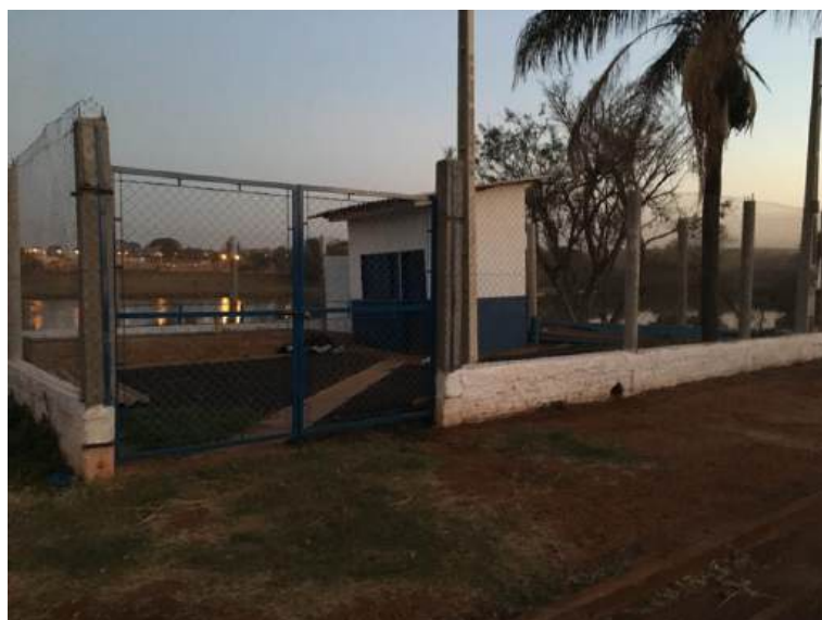
Foto 3.78 – Vista da entrada da EEE Tropical
