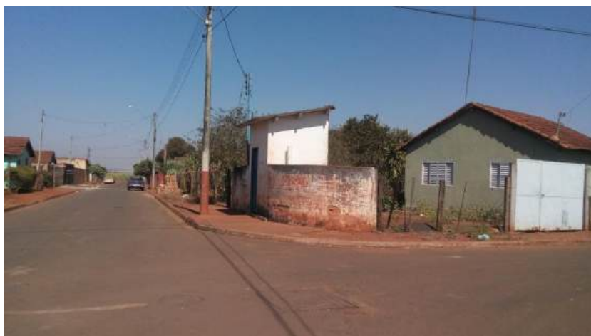
Foto 3.94 – Abrigo do quadro de comando da elevatória
