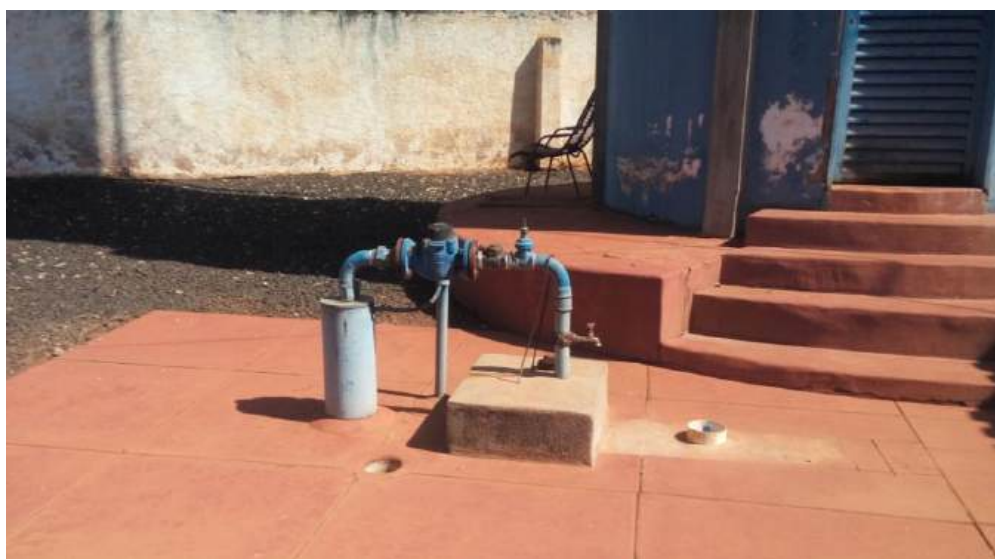
Foto 3.45 – Detalhe do Poço PP-01 de Aparecida do Salto.
