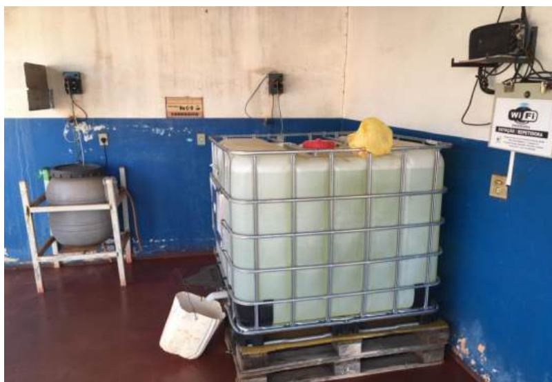
Foto 3.48 – Detalhe da dosagem dos produtos químicos de Aparecida do Salto.
