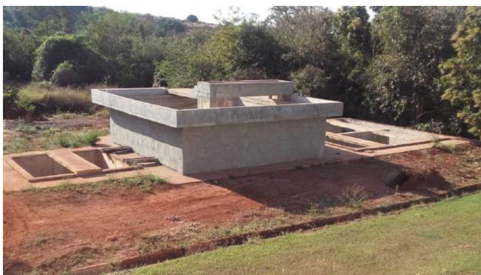
Foto 3.11 – Vista da construção do futuro sistema de tratamento de lodo da ETA
