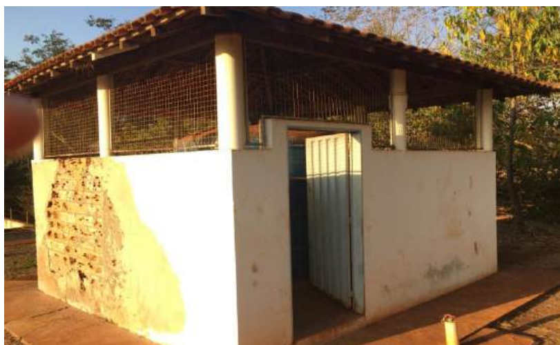
Foto 3.89 – Vista do depósito e sistema de desinfecção
