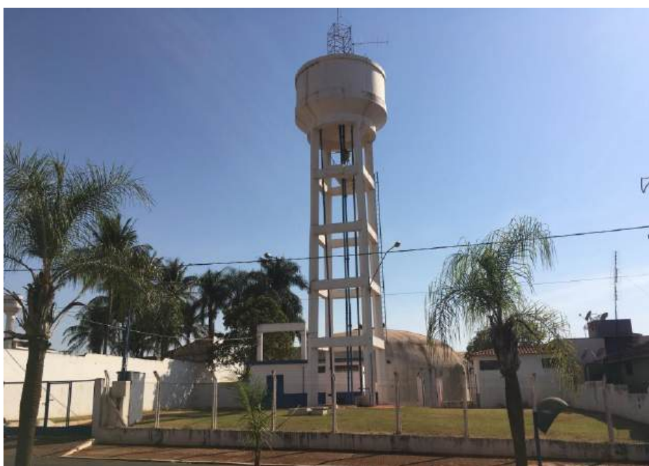
Foto 3.15 – Vista do reservatório elevado do Centro de Reservação Estação – 50 m 3
