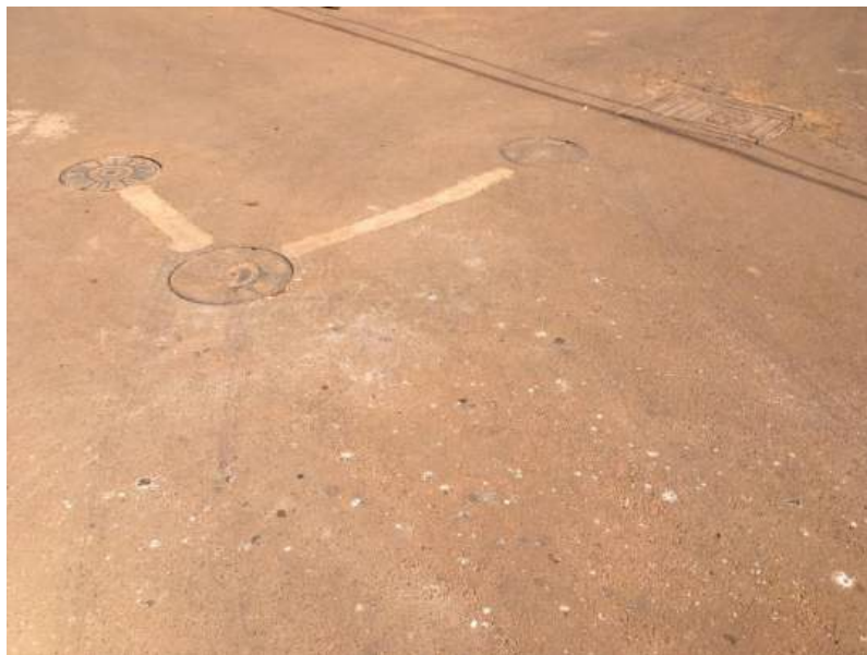
Foto 3.93 – Vista dos tampões da Estação Elevatória de Esgoto
