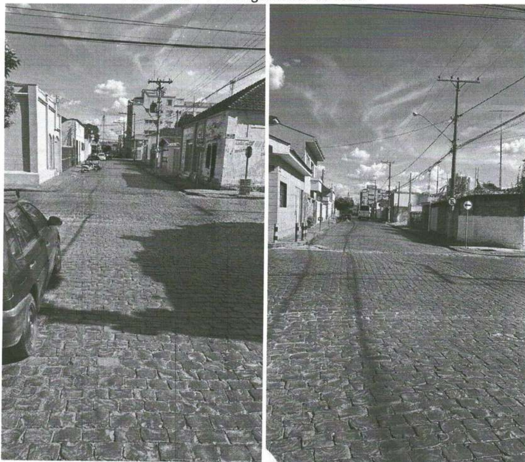
Foto 8 e 9 – Prolongamento de rede
