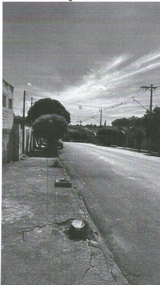
Foto 13 – Prolongamento de rede
