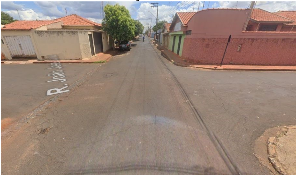
Foto 11 – Prolongamento de rede
