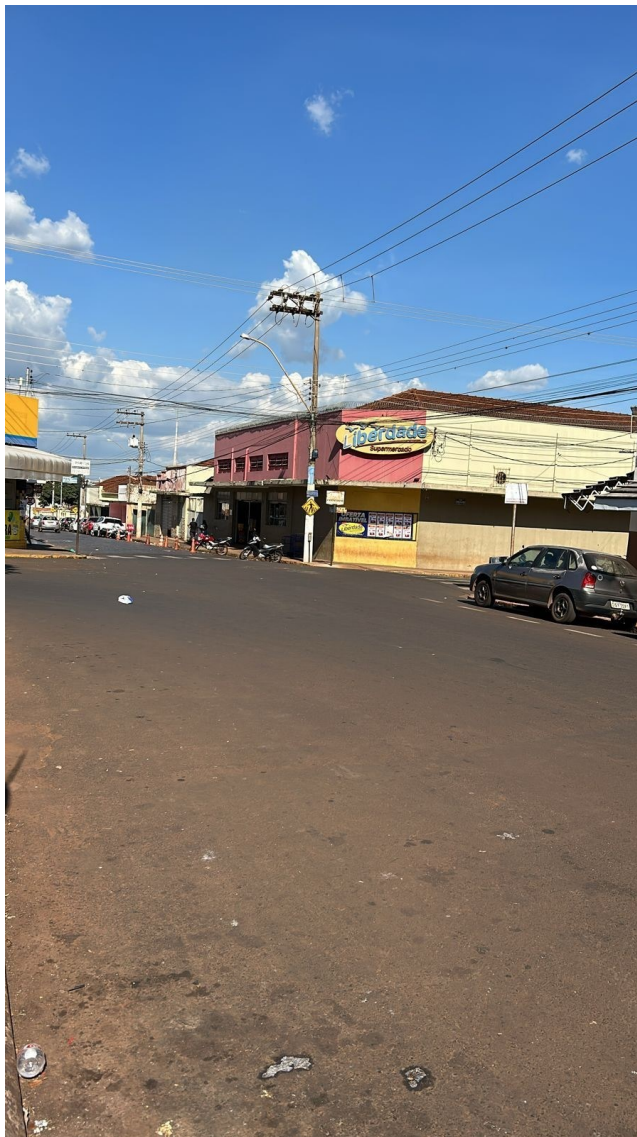
Foto 3 – Conexão na rede existente 150 mm
