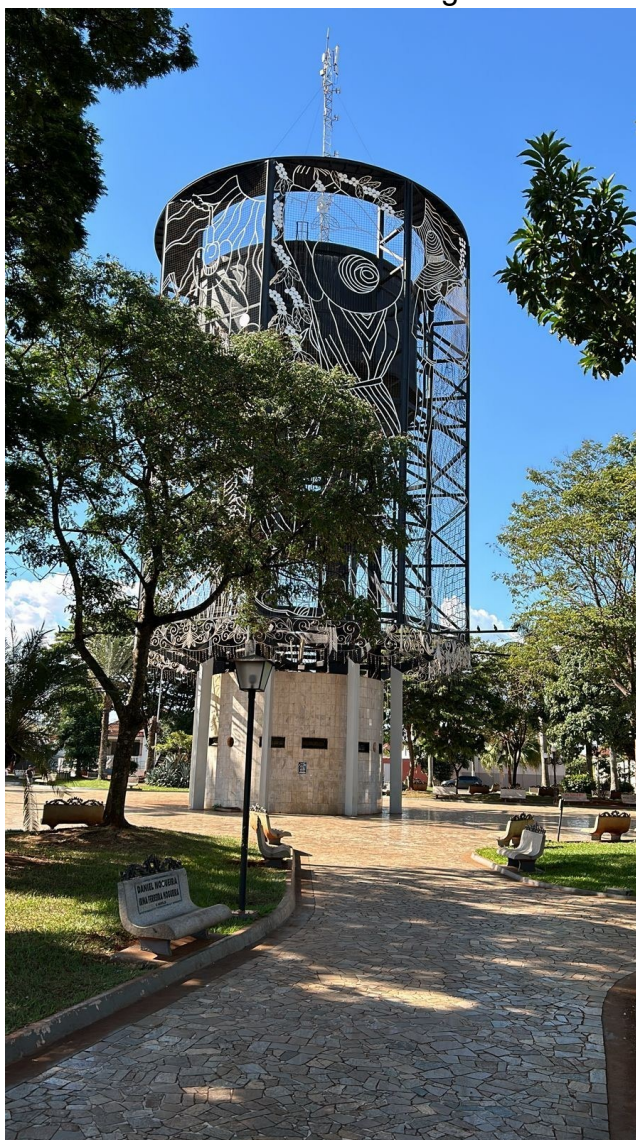
Foto 1 - Saída da caixa d'água
