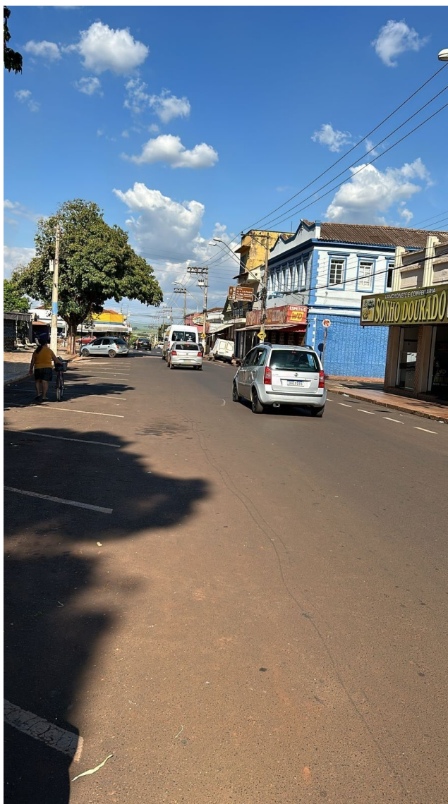
Foto 2 – prolongamento até conexão
