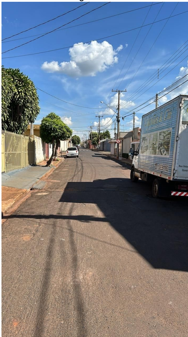
Foto 12 – Prolongamento de rede
