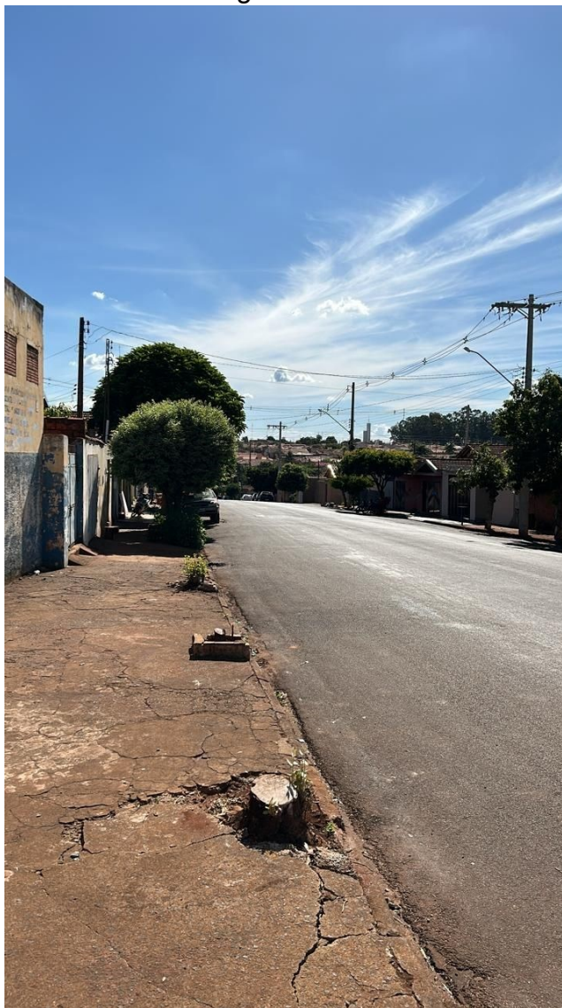
Foto 13 – Prolongamento de rede
