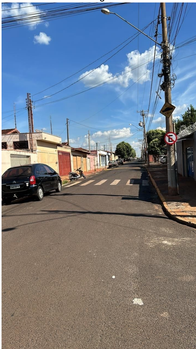
Foto 10 – Prolongamento de rede
