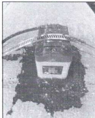
Fotos modelos de Macromedidor instalado com cinta abraçadeira
